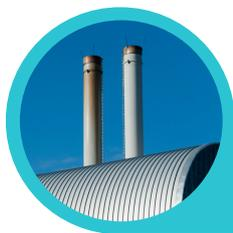
Des analyseurs placés sur les cheminées permettent de s'assurer du bon fonctionnement des installations du traitement des fumées en contrôlant en continu les rejets dans l'atmosphère. Ce dispositif est complété par des prélèvements semestriels opérés par un organisme externe.
